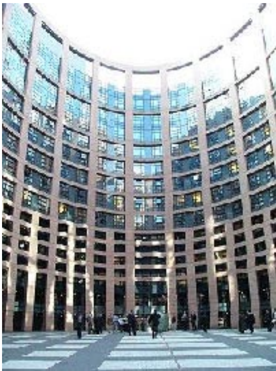
Cour intérieure du bâtiment
